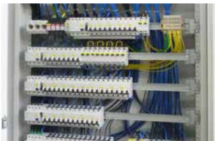
Installationsverteiler
