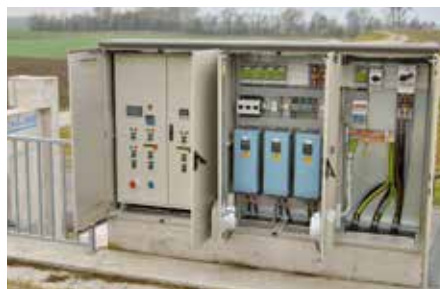
Freiluftschaltschrank Pumpwerk
