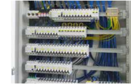
Installationsverteiler
