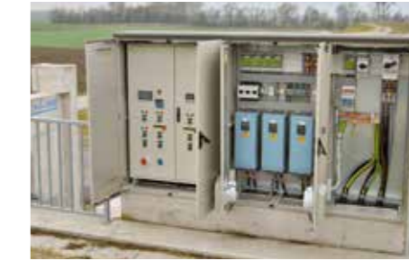
Freiluftschaltschrank Pumpwerk
