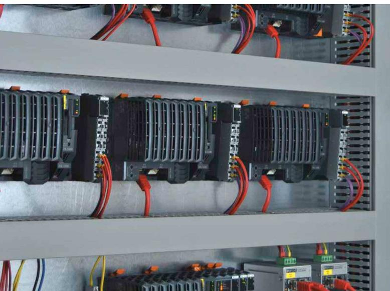
Die Kommunikation mit den redundanten Leitrechnern erfolgt über je einen X20-Controller pro Systemabschnitt in der Betreiberzentrale.
