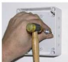
SNA-Dübeln alleine setzen
