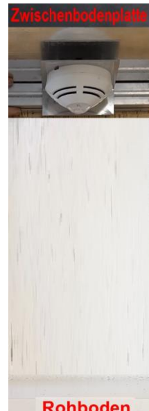
mit Staublech an der Bodenunter- konstruktion
