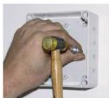
SNA-Dübeln alleine setzen
